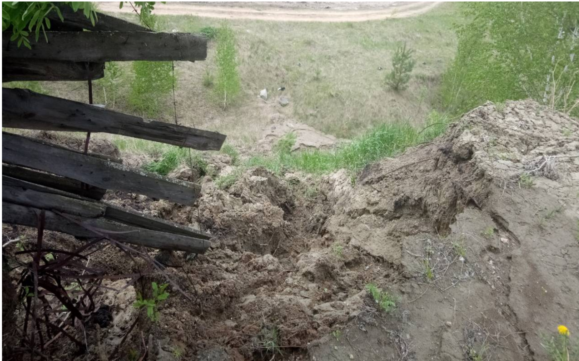
Последствия утечки ...пос. ..., июнь 2018 (1 авария)
