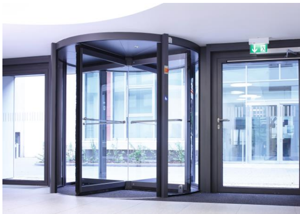
Двери KTV 4A и распашные привода ED 100 на входе
