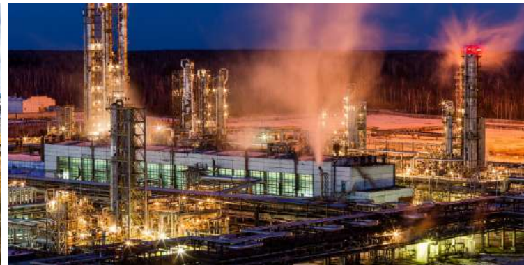
ТомскНефтеХим, г. Томск Установленные системы: система пожарной безопасности
