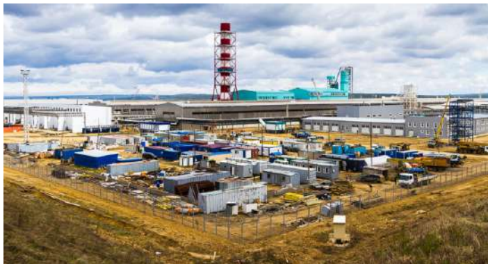
Богучанский алюминиевый завод, п. Таёжный Установленные системы: пожарная сигнализация, охранная сигнализация
