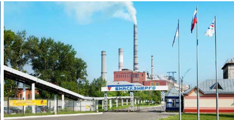
Бийская ТЭЦ, г. Бийск Установленные системы: пожарная сигнализация, автоматика пожаротушения
