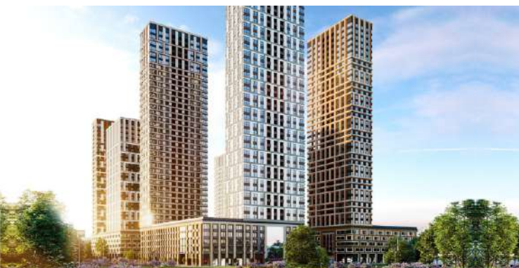
Level Амурская, г. Москва Установленные системы: адресная пожарная сигнализация, автоматика дымоудаления, система оповещения и управления эвакуацией, автоматическое пожаротушение
