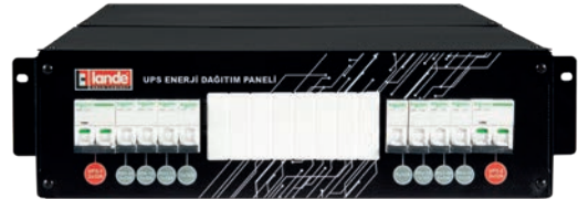
Распределительная панель ИБП
