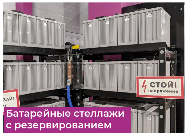
Модульные ИБП Delta, 2(N+1)
